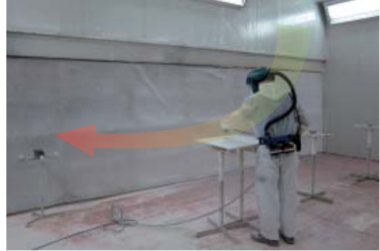
BILD 1. Spritzen unter Hochdruck in der Spritzkabine. Der Pfeil gibt die Luftströmung des Absaugsystems an. Grün bedeutet eine niedrige, rot eine hohe Nanopartikelzahl.
